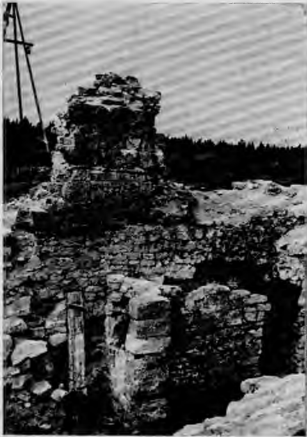
47. att. Skats uz austrumu muri. ar piebūvēto šaujamtelpu.
